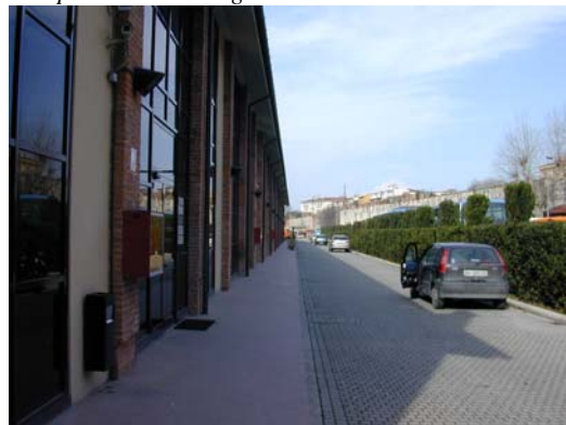
Prospetto interno lungo le mura urbane
