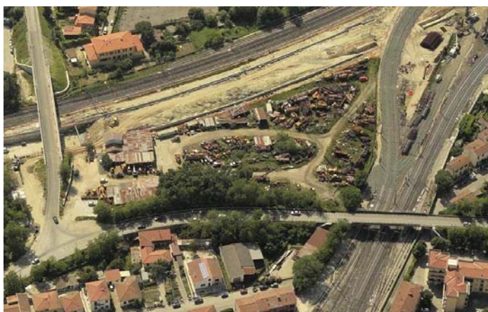
scheda-norma 27.2 L'area durante i lavori di sistemazione delle sedi ferroviarie adiacenti.
