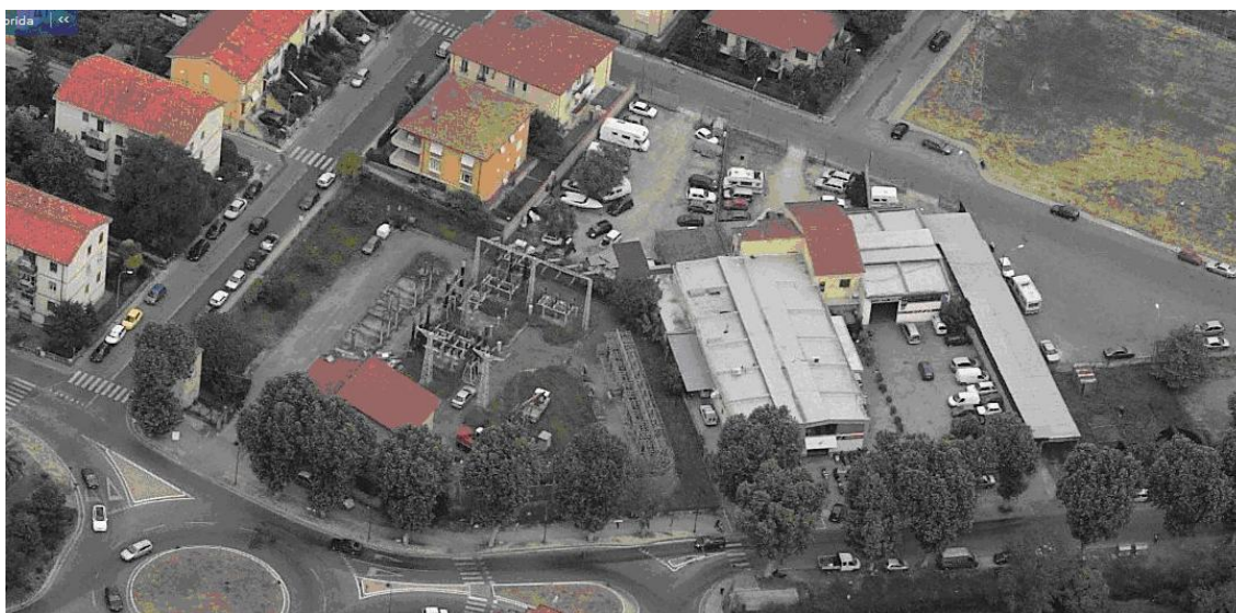
scheda-norma 10.1 – il margine meridionale, con la cabina primaria Enel e le attività presenti
