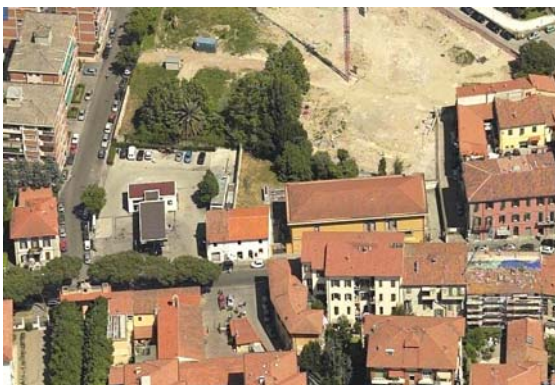
scheda-norma 9.1 – in alto il comparto 2 in corso di realizzazione (oggi ultimato), al centro il comparto 2 con il distributore e l'edificio Telecom degli anni '60
