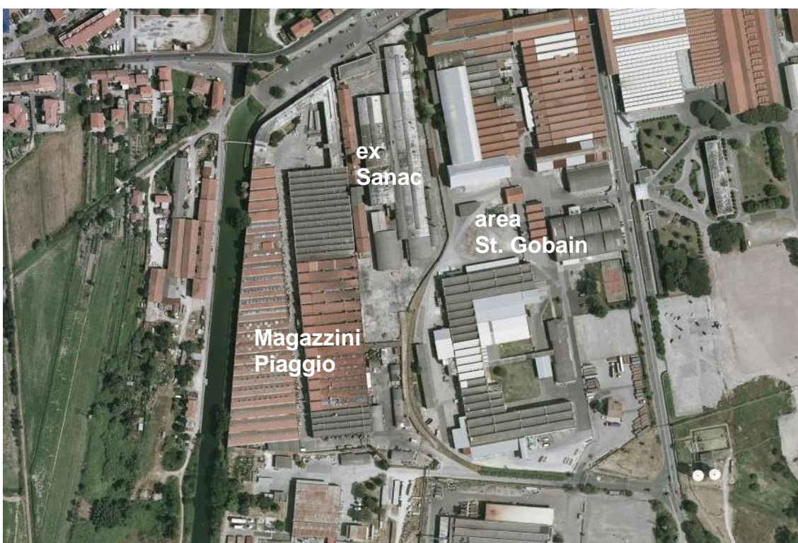
Il margine nord dell'U.T.O.E. n. 26 – Da sinistra: il magazzino Piaggio (scheda-norma 26.3), gli immobili ex Sanac (in corso di recupero), l'area St. Gobain
