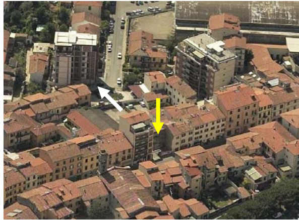
scheda-norma 29.2 – Il rudere su via Cattaneo ed il collegamento con via Marco Polo. In alto a destra uno dei capannoni compresi nella scheda-norma 29.1
