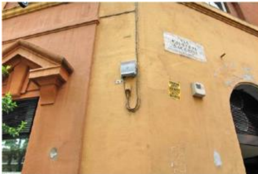
Esempi di installazione PTA in facciata
