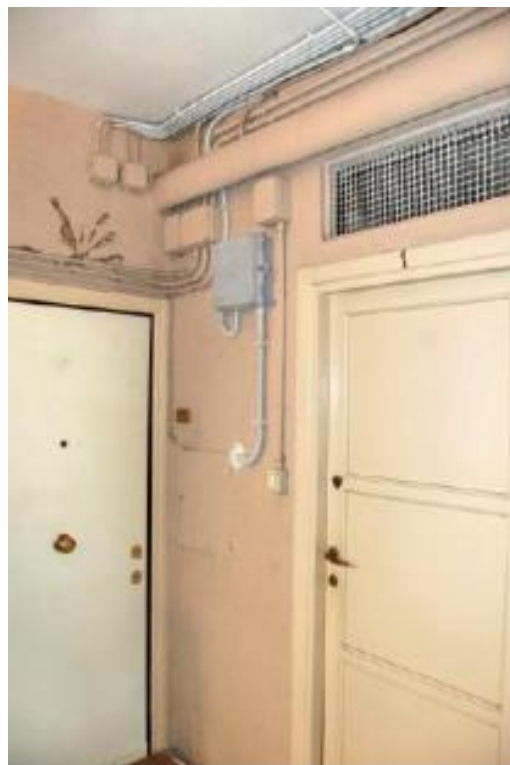
Esempi di installazione del PTA
