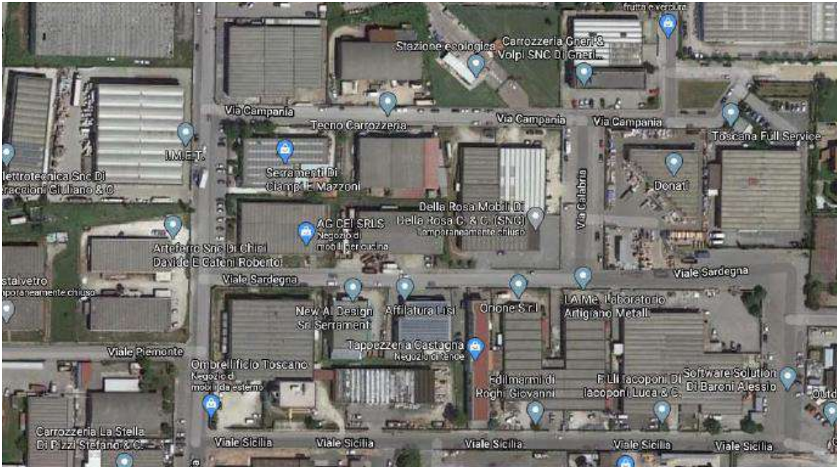
Sistema insediativo oggetto di verifica
