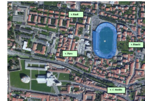
Fig. 4.13 Localizzazione dello stadio di calcio.
