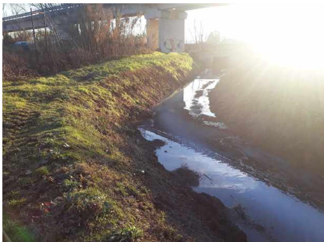
Figura 4.4 Apertura dello scolare al di sotto della FI-PI-LI, le cui quote troppo elevate causano il rigurgito delle acque verso monte.
