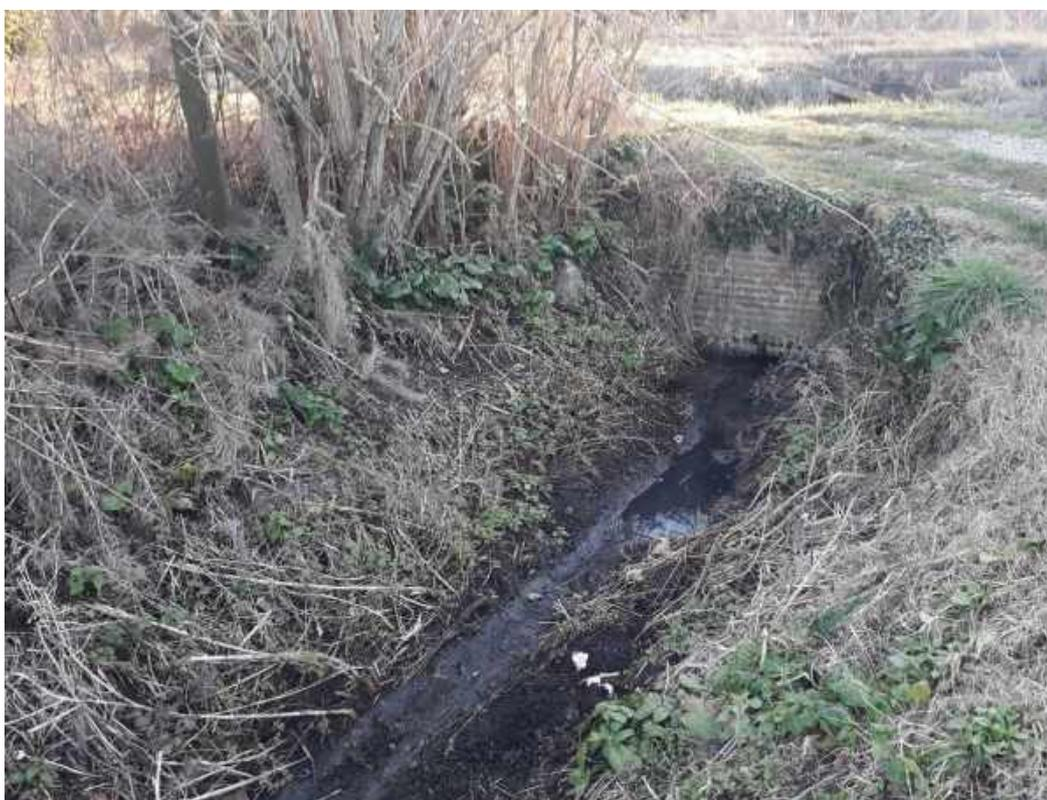
Figura 4.2 Interrimento dell'imbocco della prima parte di tombinatura dell'Arginone di Putignano in zona Le Bocchette, a monte della ferrovia.
