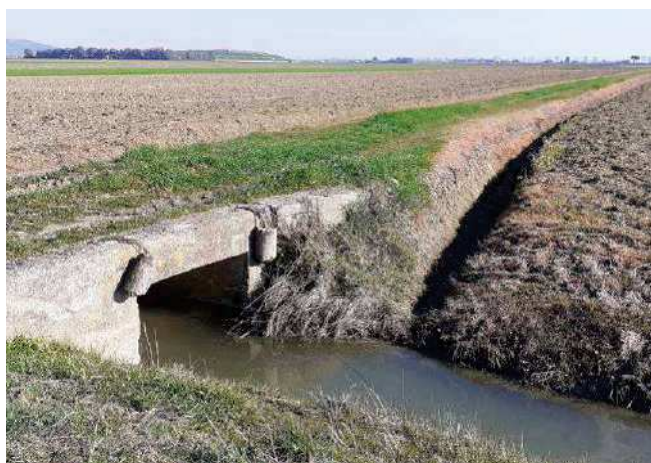
2 - Particolare sull'altro lato del ponticello di attraversamento della viabilità campestre sul reticolo in prossimità dell'area umida (vista da sud verso Nord est).
