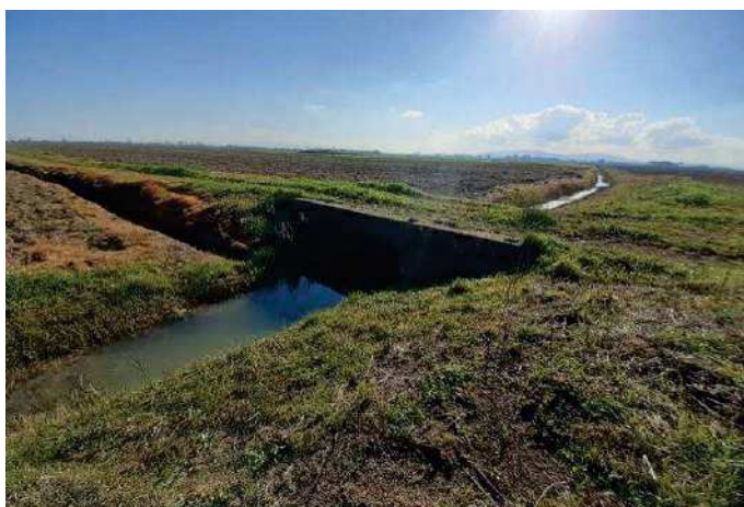
1 – Particolare ponticello di attraversamento della viabilità campestre sul reticolo, in prossimità dell'area umida (vista da Nord verso Sud).
